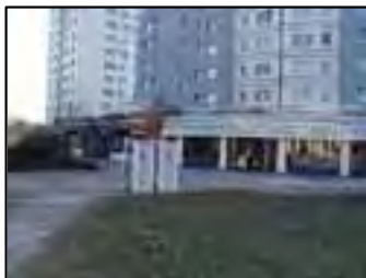
Fehlende Hinweisschilder und auf Grund der Hochhäuser keine Einsehbarkeit von Seiten der Landsberger Alle
