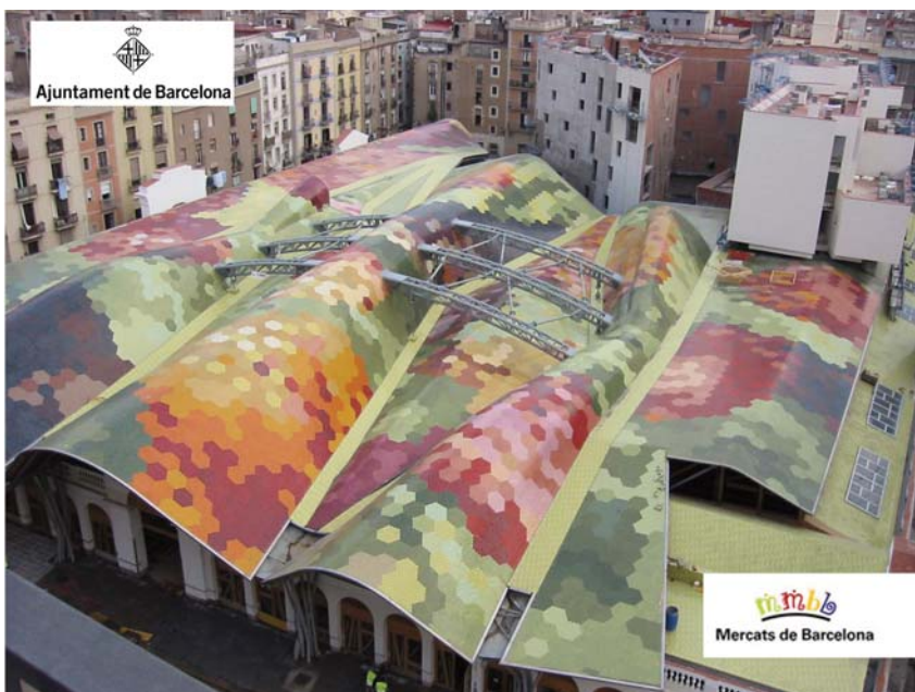
Der Mercat de Santa Caterina in Barcelona wurde zum multifunktionalen innerstädtischen Zentrum ausgebaut. Quelle: IMMB-Mercats de Barcelona
